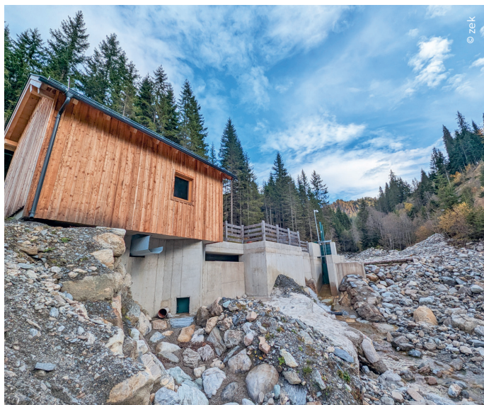
Die komplett neu gebaute Hauptwasserfassung des Ausleitungskraftwerks befindet sich am Lambach.
