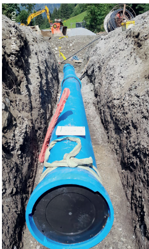
Der Kraftabstieg der Anlage besteht zur Gänze aus Gussrohren mit der Dimension DN500 von der Tiroler Rohre GmbH.
