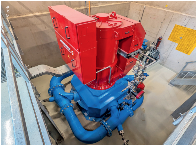
Der Kärntner Wasserkraftallrounder EFG Turbinenbau fertigte eine leistungsstarke Pelton-Maschine mit 516 kW Engpassleistung.
