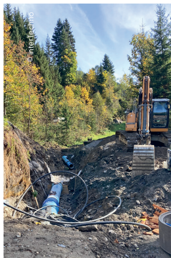
Der Kraftabstieg der Anlage besteht zur Gänze aus Gussrohren mit der Dimension DN500 von der Tiroler Rohre GmbH.
